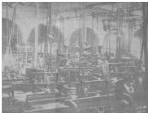
Fábrica textil en el convento de San Francisco
